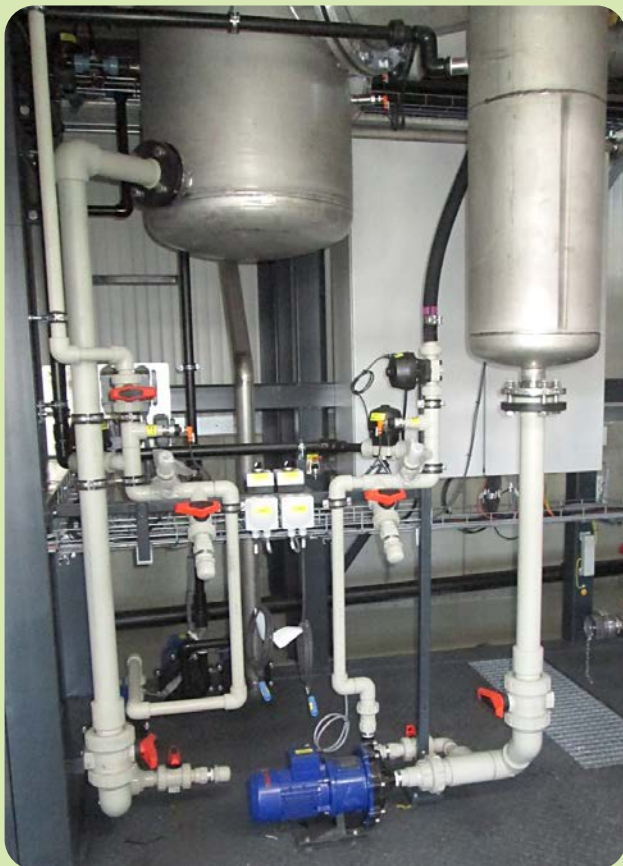
Medición del pH en el lavador de vapor
