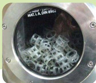
Corpo di riempimento nello scrubber a vapore
