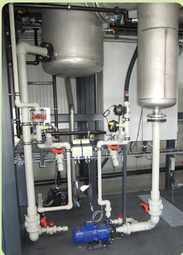
Misurazione del pH nello scrubber a vapore
